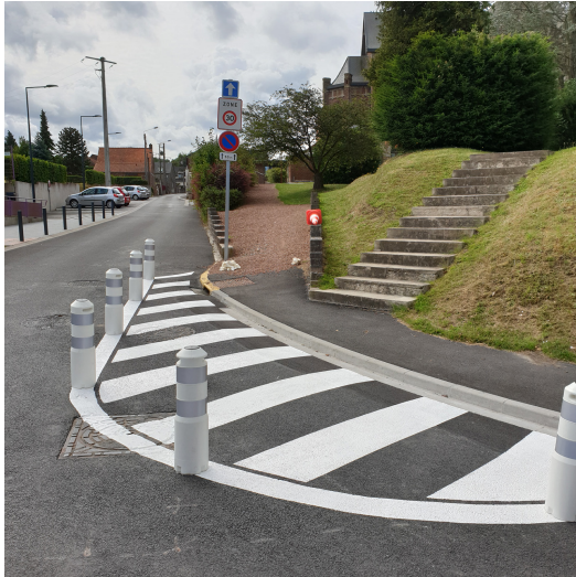
Sécurisation de la sortie de l'école primaire
