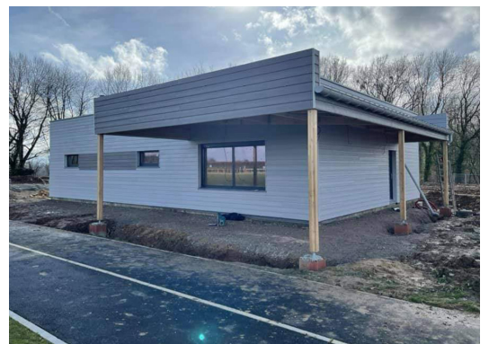
Construction des vestiaires du terrain de football
